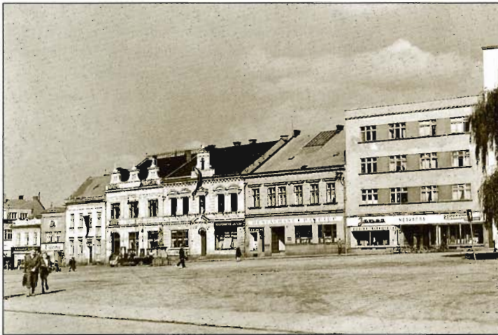
Východní průčelí náměstí Míru
